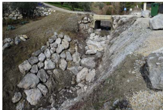
Février 2011 Protection du seuil par enrochement
