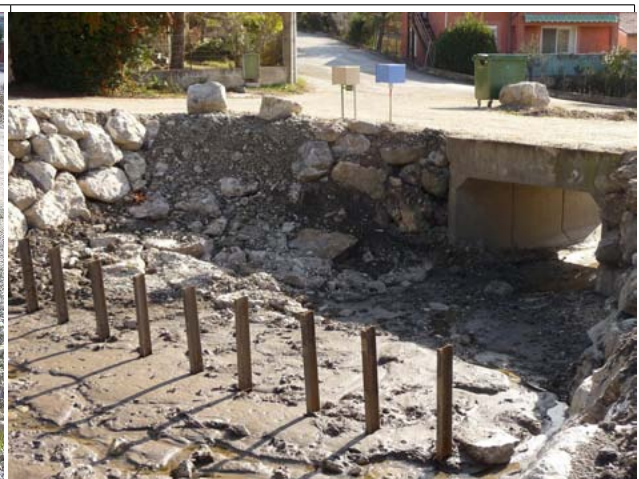
Février 2011 après réalisation du piège à embâcles
