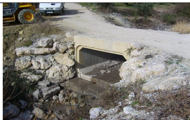
Seuil sur ouvrage amont
